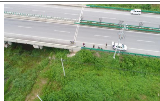
桥梁边坡植被防护
