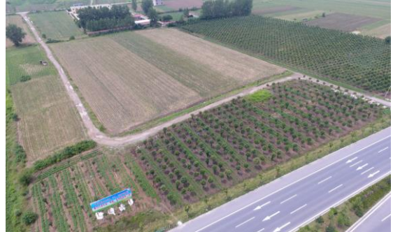
拆除硬化场地
