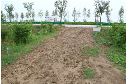
已清除路面碎石并撒播草籽
