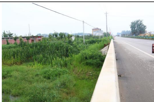
桥梁边坡植被防护
