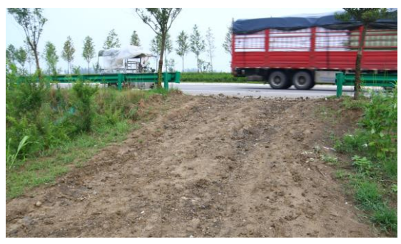
已清除路面碎石并撒播草籽
