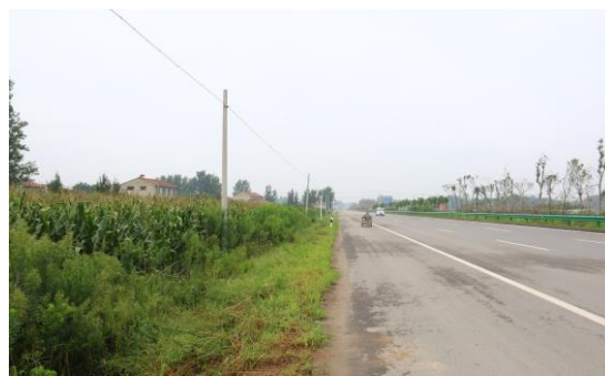
路基边坡植被防护
