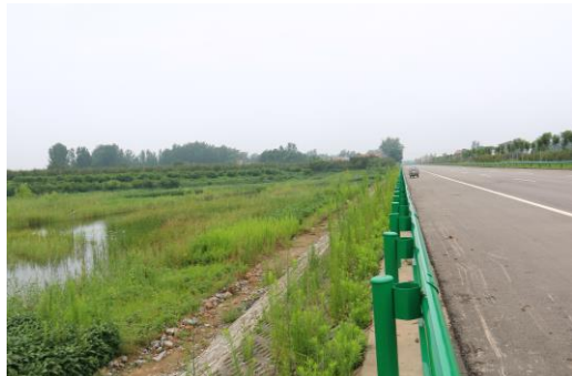
路面边坡生态防护
