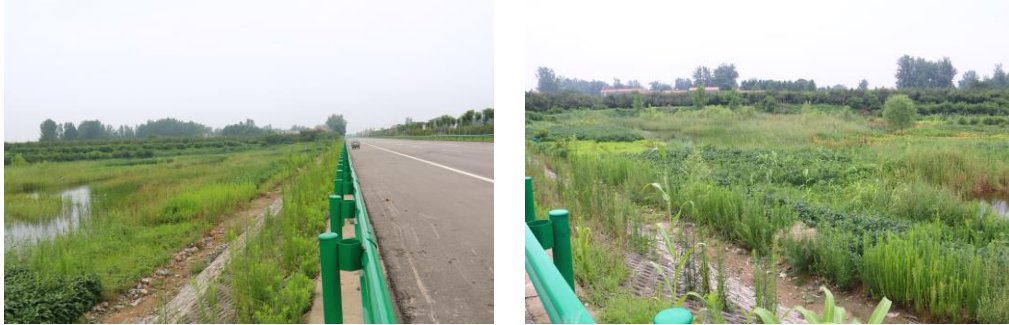
图 1.7 路基边坡植被防护
