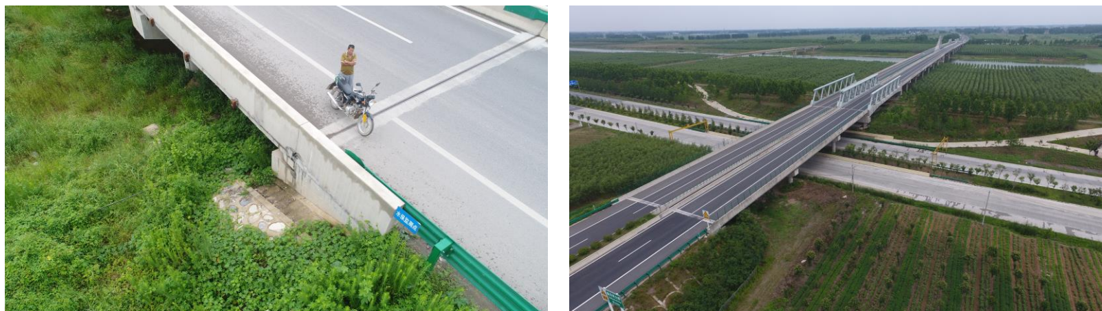
图 1.9 桥梁边坡植被恢复
